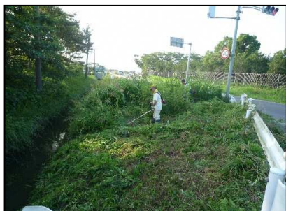
( 農道法面の草刈り )
