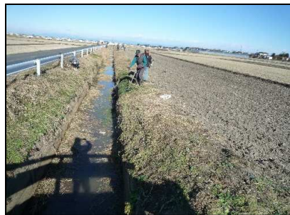
( 水路護岸の草刈り )
